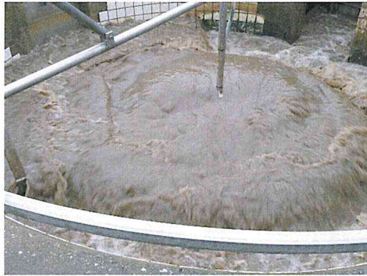
Verteilerbauwerk bei 270 l/s
