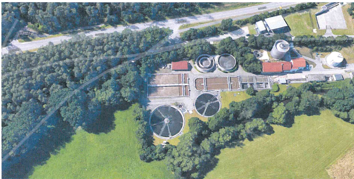
Ansicht auf die Kläranlage aus Süden (Quelle: Google Maps)
