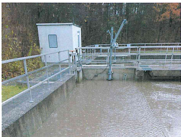
Hier sollte die Ablaufkante sichtbar sein, diese ist überflutet,
